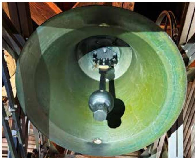
Durch die Änderung des Klöppeldrehpunktes und den Einsatz eines leichteren, statischen Fallklöppels, kann dem starken Prellschlag entgegengewirkt werden.
