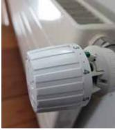
Mit einem Thermostatventil lassen sich die, je nach Nutzung, unterschiedlichen Temperaturen in den Zimmern regeln.
