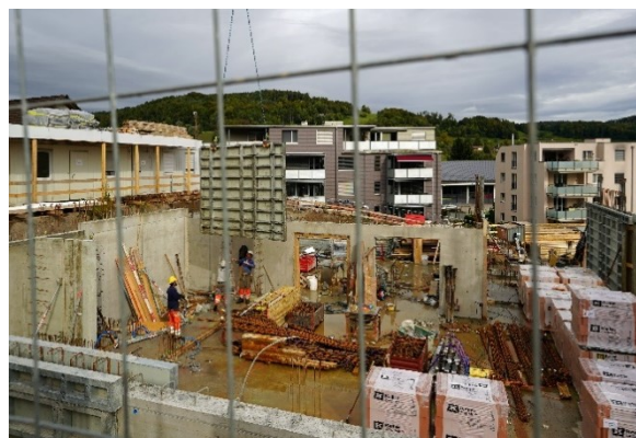
Bau Gebäude „almacasa“
