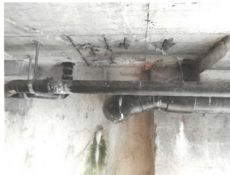
Schwimmbadleitungen und Bewehrungseisen, mit zu geringen Betonüberdeckung
