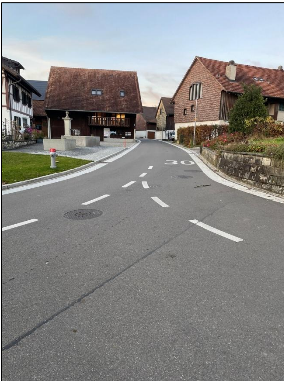
Foto 3: Bsp. Breite Ränder am Fahrbahnrand Rickenbach ZH
