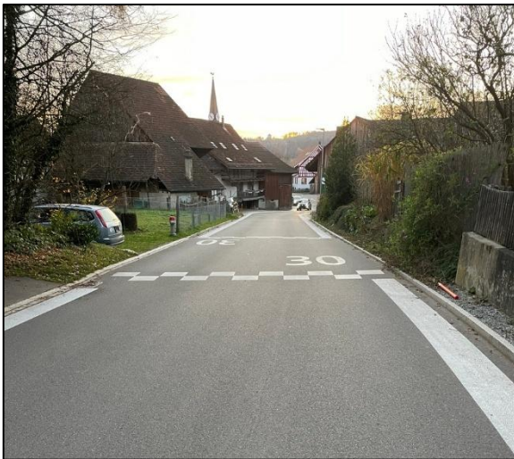
Foto 1: Bsp. Vertikal-Versatz Rickenbach ZH
