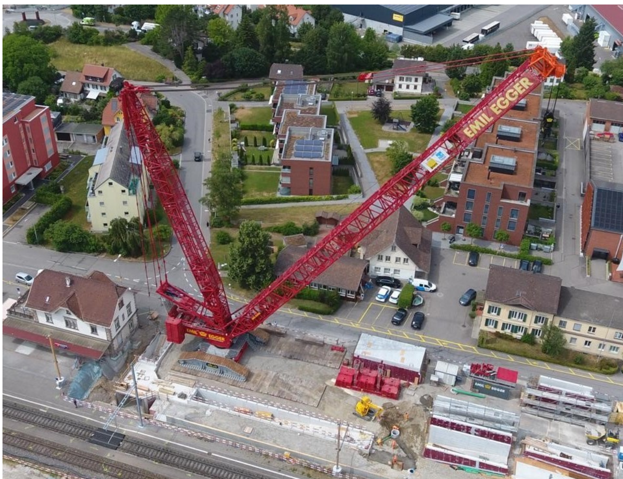
Ein Bild für das Geschichtsbuch von Pfungen: Der schweizweit grösste Raupenkran bei einem Einsatz am Bahnhof Pfungen
