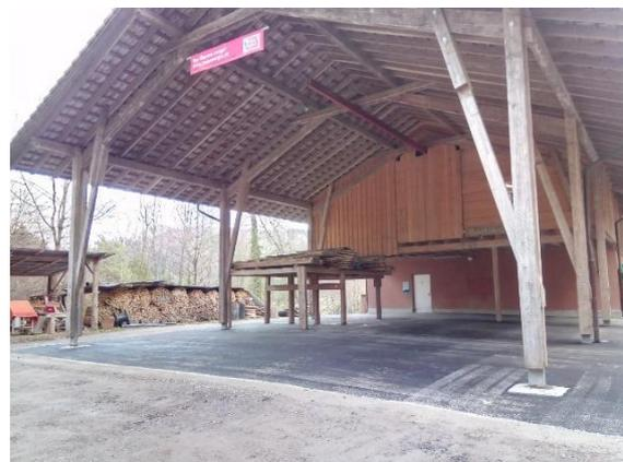
In der Brennholz- und Einstellhalle des Forsthauses konnte der Kiesboden durch Strassenbelag ersetzt werden. Die Halle kann nun bestens als Schlechtwetterarbeitsplatz genutzt werden. Das Ordnung- und Sauberhalten wird vereinfacht.
