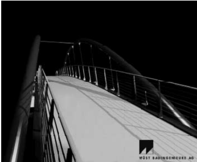
Ziel ist eine Inbetriebnahme der neuen Brücke im August 2008.
