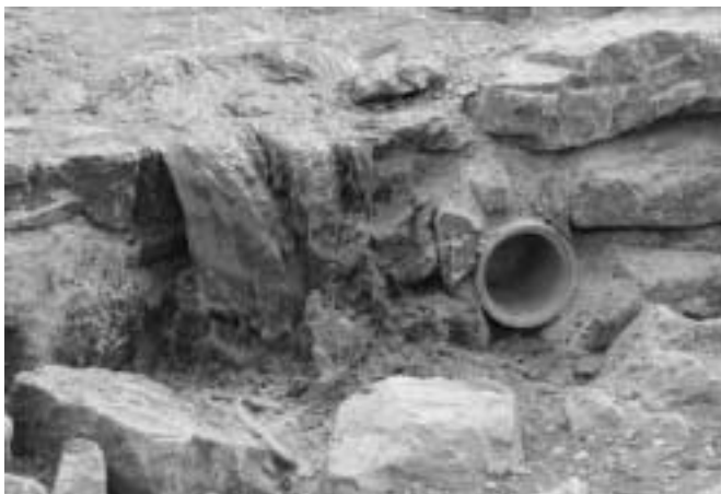
Fischunterschlupf in den Schwellen.
