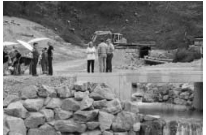
Das Tosbecken mit der neuen Brücke.
