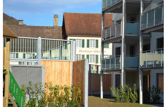
Lärmschutzwände trennen die Weiacherstrasse und das Restaurant Sternen von den Wohnblöcken.
