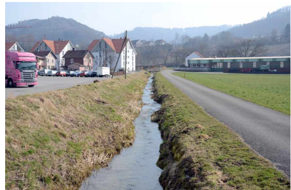
Noch fliesst der Mülibach im gewohnten Bachbett in Richtung Töss.
