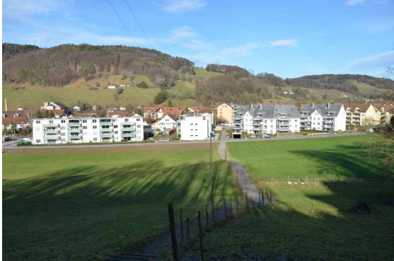
Blick auf das neue Quartier Grosswiesen.
