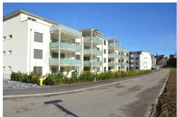
An der Grosswiesenstrasse sind weitere Wohnblöcke entstanden.
