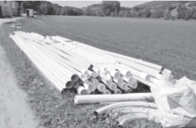
Laufend wird Material angeliefert ...
