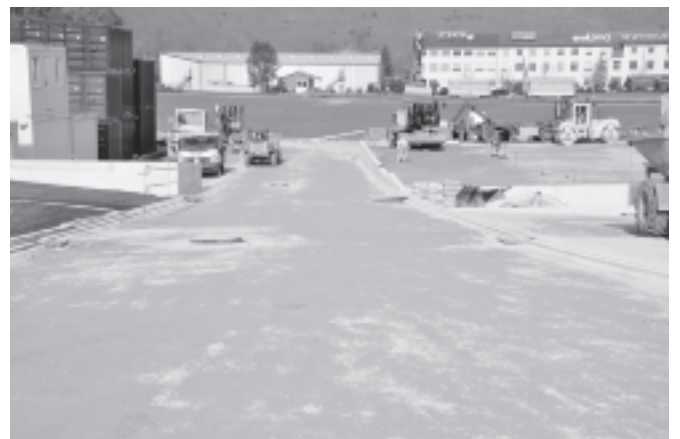
Die Allmendstrasse ist für den Belageinbau bereit.
