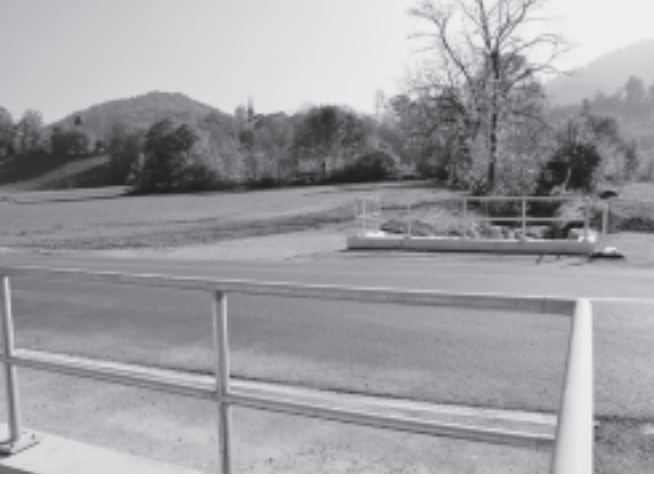
Am Mülibachdurchlass wurde ein Geländer montiert. Damit ist dieses Bauwerk fertigerstellt.
