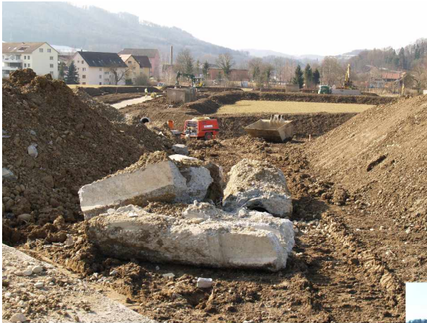
25. Februar 2009 Die ersten Erdbewegungen sind sichtbar.
