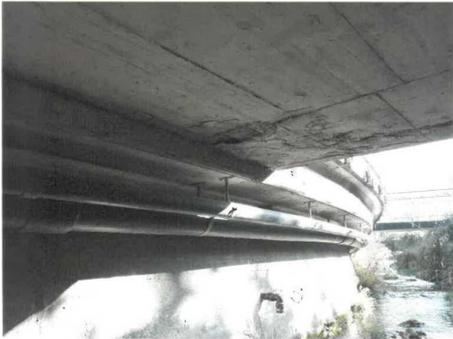
Abplatzungen an der Decke im Bereich des Einlaufs in den Durchlass
