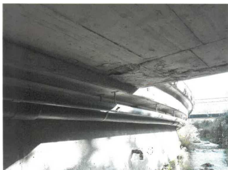
Abplatzungen an der Decke im Bereich des Einlaufs in den Durchlass Bestehende Leitungen des Schwimmbades
