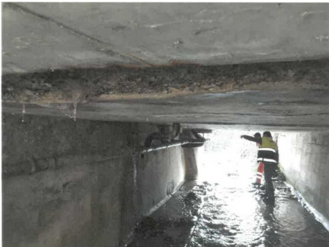
Foto entgegen der Fliessrichtung (Übergang zum Durchlass unter dem Schwimmbad)
