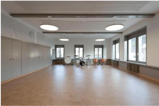
An einem grossen Teil der Wände im Altbau sowie im Anbau mit der neuen WC-Anlage und dem Personenaufzug, wurde ein neuer Grund- und Deckputz erstellt sowie Akustikdecken und -Wandverkleidungen in den neuen Räumen „Multberg“ und „Bläutschli“ montiert. Im Raum „Multberg“ wurden die Decke und die Unterzüge mit Brandschutz-
